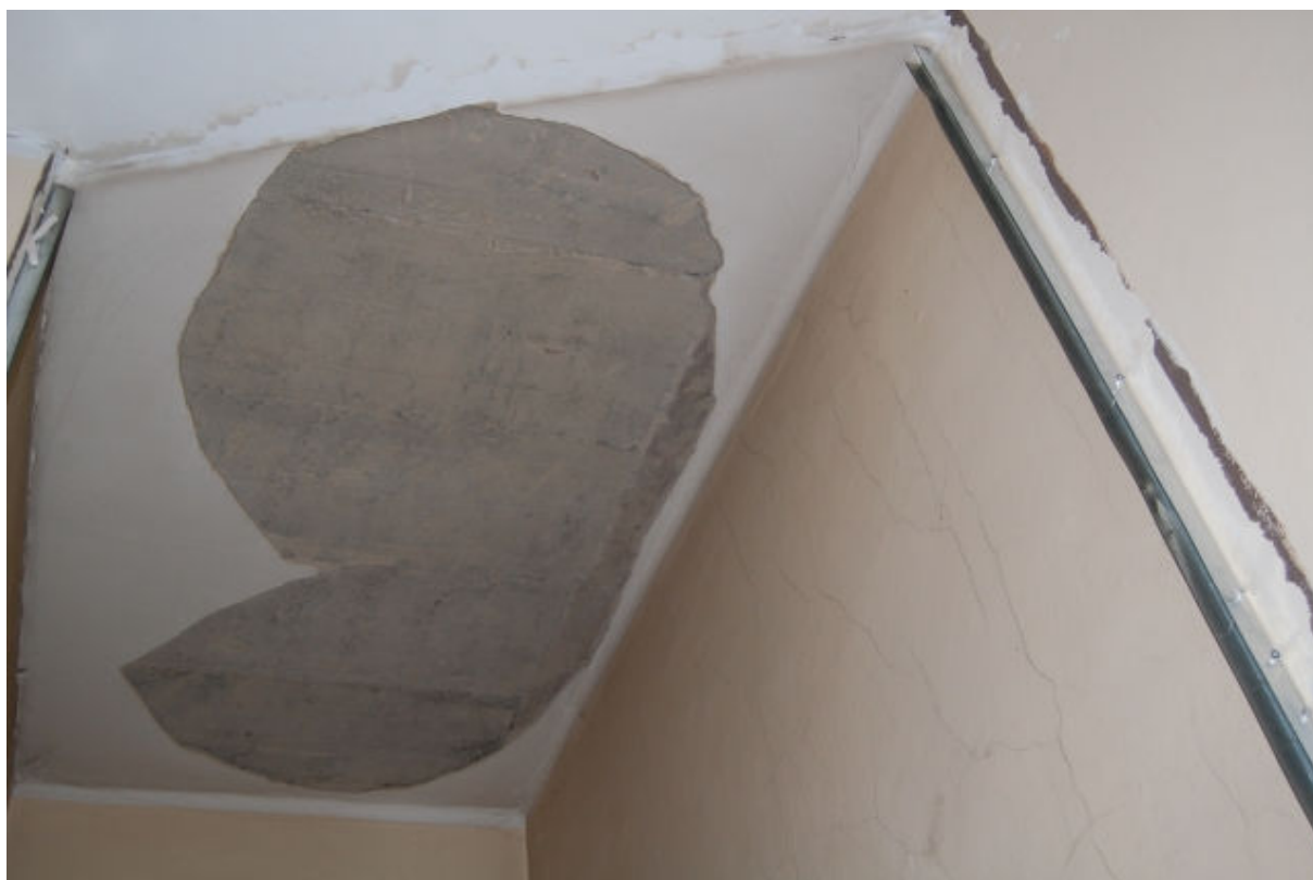
ODKRYWKA 2 – MIESZKANIE NR 4 – BELKA STROPOWA I WYPEŁNIENIE STROPU PŁYTAMI BETONOWYMI
