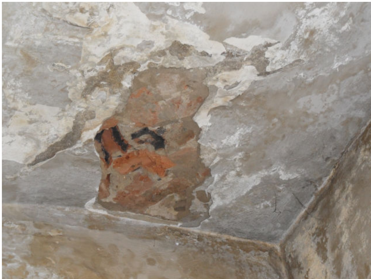
ODKRYWKA 1 – MIESZKANIE NR 4 – UKŁAD CEGIEŁ W SKLEPIENIU NAD WYKUSZEM
